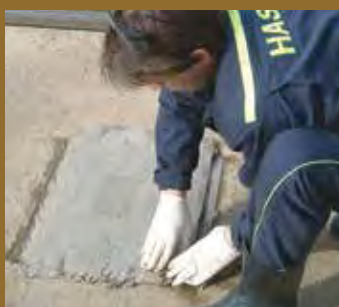
Utěsnění kanalizační vpusti
